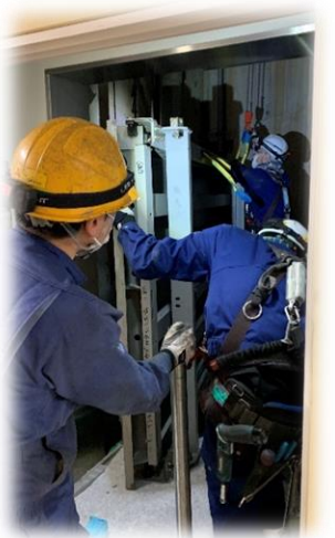
EVの工事風景
